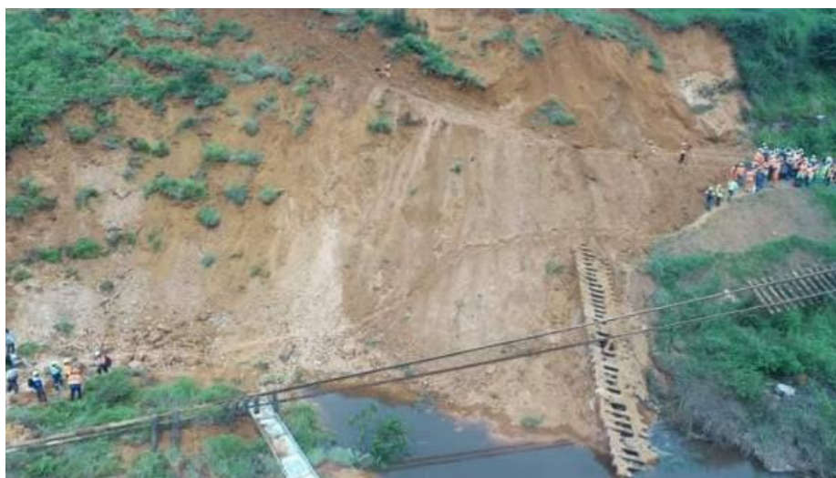
Figure 44 Images du déraillement du 24 décembre 2022 entre les gares d'Offoué et de Boué
