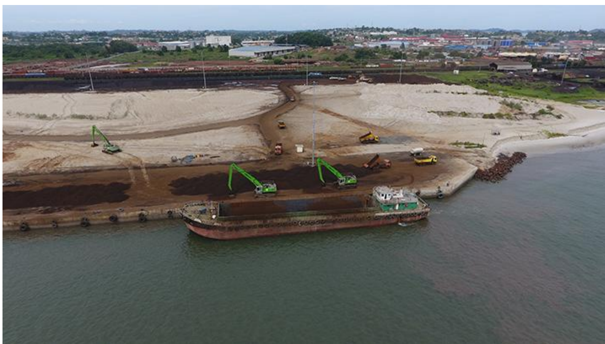
Figure 35 Quai du nouveau port minéralier d'Owendo (OMP)
