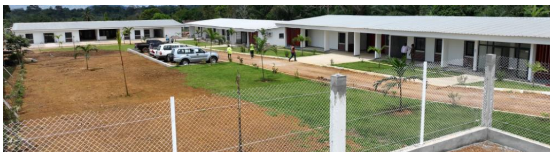
Figure 50 Le centre de santé de Mitxic réalisé dans le cadre du PASS2
